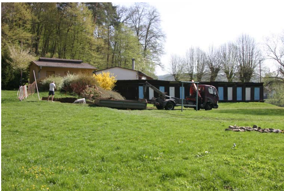
Hloubka výkopu je značná, z bagru již je vidět pouze střecha
