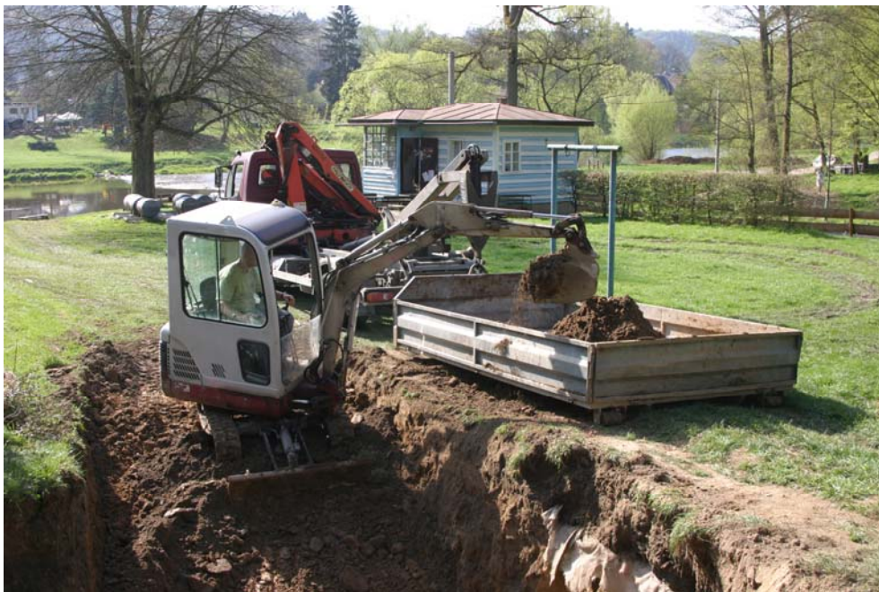
Místo podzimních plískanic jsme zahájili práce na hloubení výkopu pro čističku odpadních vod až na jaře
