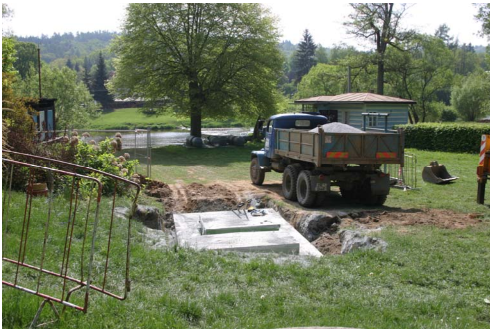
Do hlubokého výkopu byla spuštěna čistička
