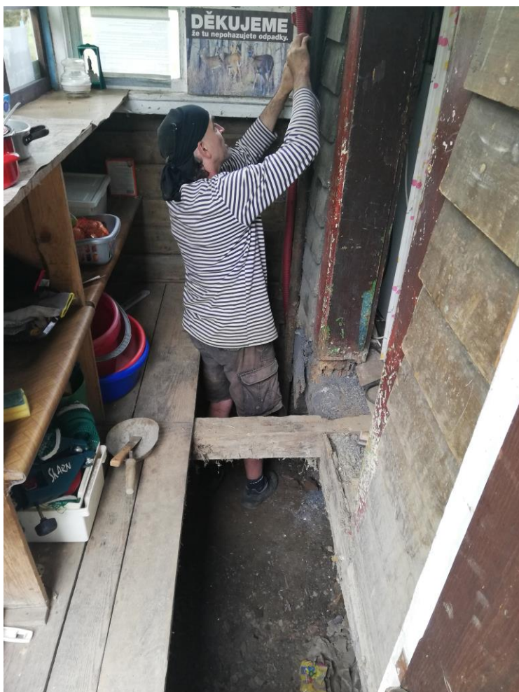
Zavedení nového přívodu elektriny do domečku
