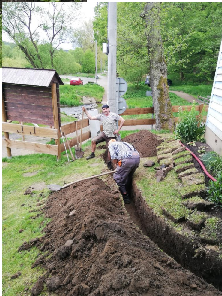
Výkop nového přívodu elektriny
