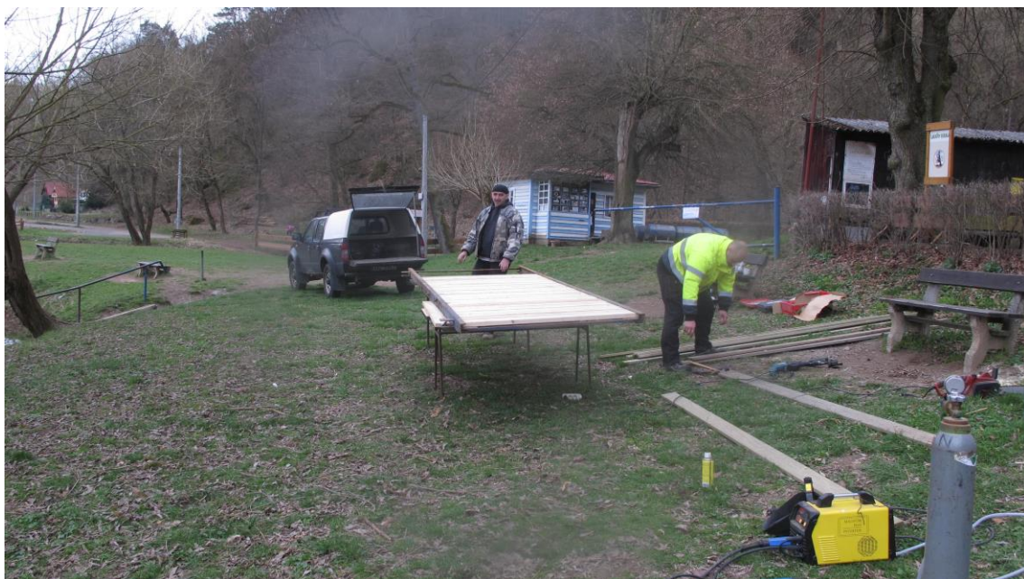
Výměna prken na nájezdu pro loď pro přístaviště ve Zlenicích
