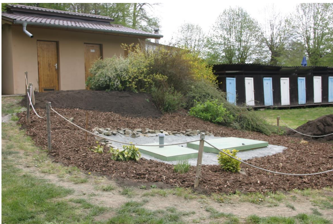
Nakonec šest kubíků hlíny na díru po bývalé jímce místo štěrkového zásypu
