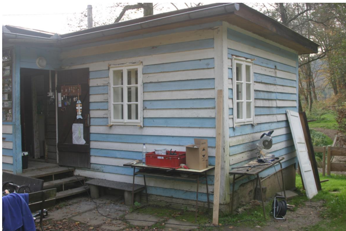
Troje nová dvoudílná okna na svých místech a nové dveře do interiéru chaloupky
