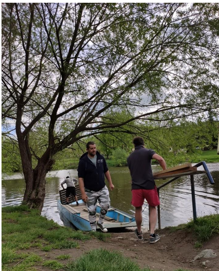
Instalace nových protiskluzových podlážek
