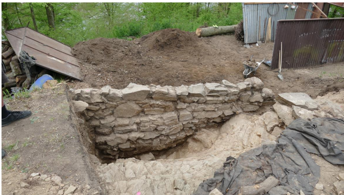
Vnitřní nádvorní líc zdiva hospodářské zástavby
