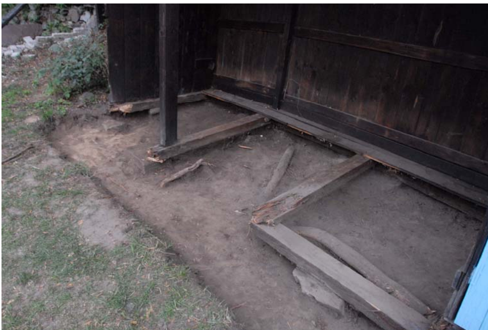
Uhnílé trámy roštové konstrukce byly nahrazeny
