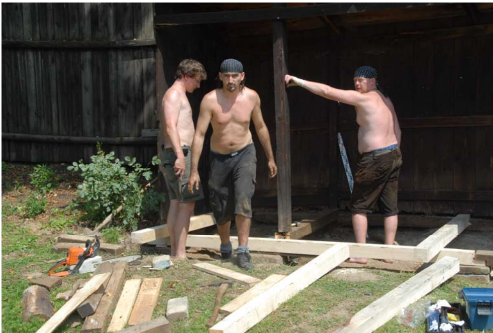
Výměna vazných trámů roštové konstrukce kabin
