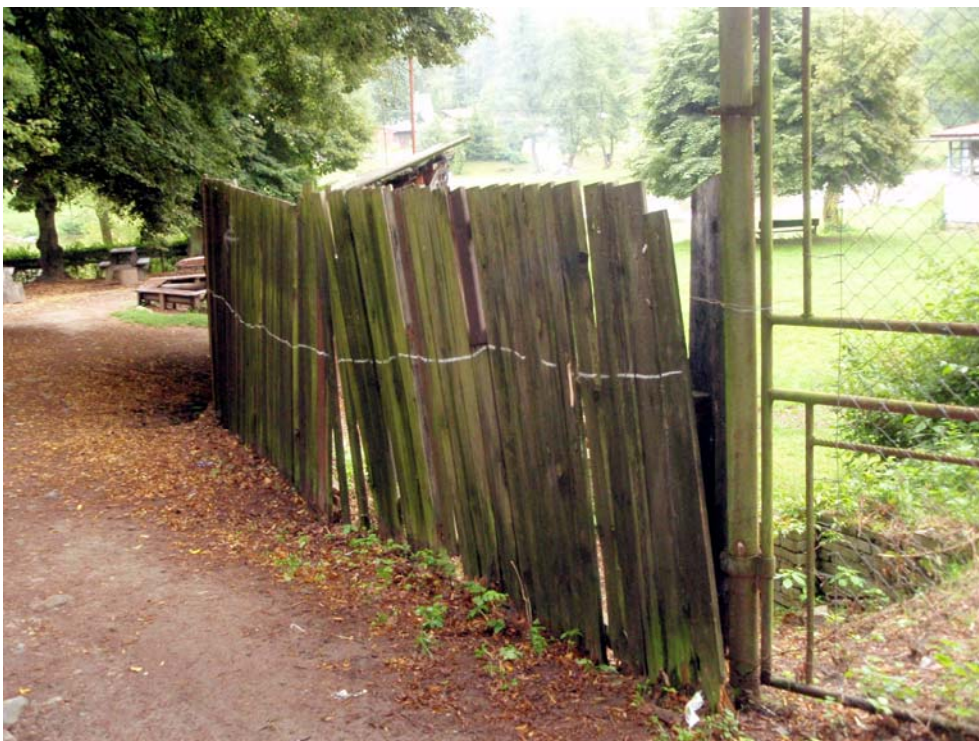
Plot hrozící zřícením byl zpevněn a narovnáán
