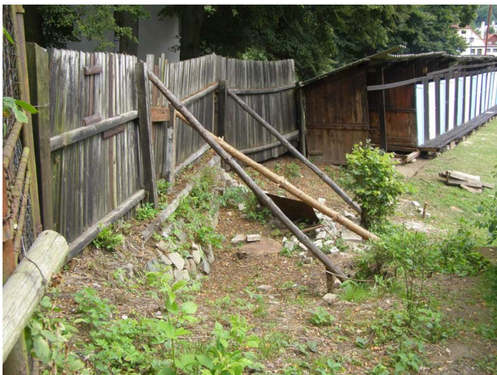
Provizorní zajištění plotu
