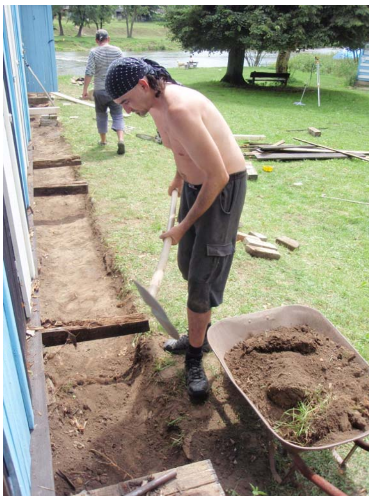
Odtěžení naplavené hlíny
