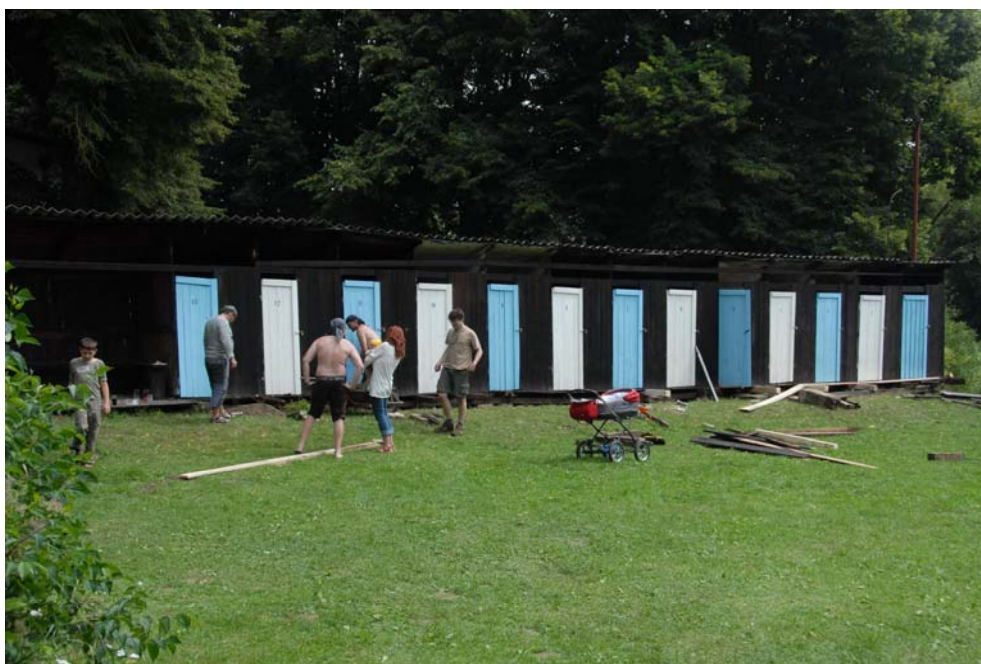
Oprava konstrukce kabin a ochozu
