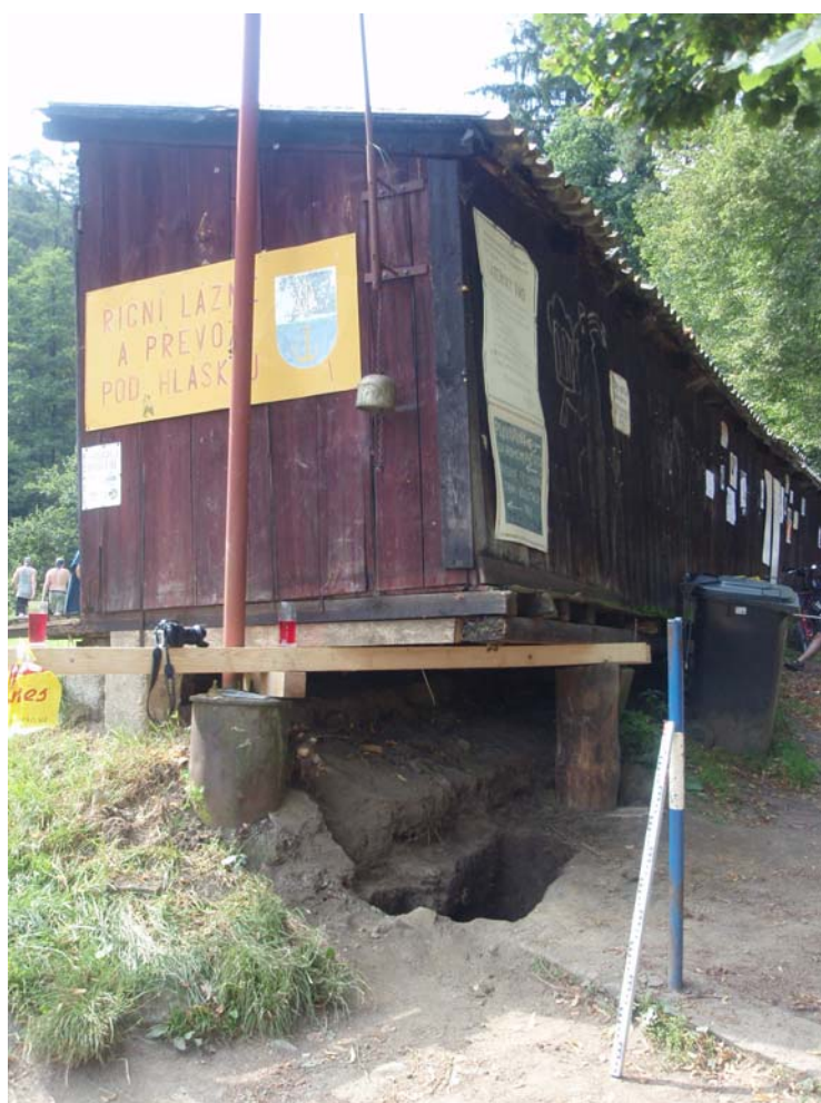
Pod nárožím zvednutým na provizorní konstrukci byly kopány nové základy nároží
