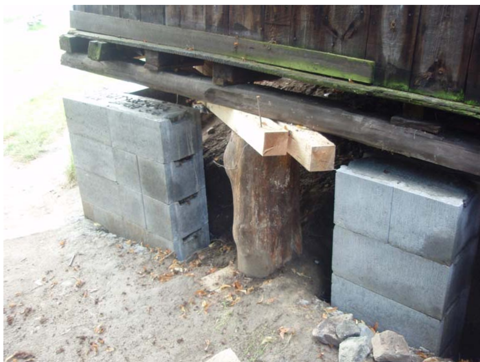
Před definitivním usazením konstrukce kabin na původní místo
