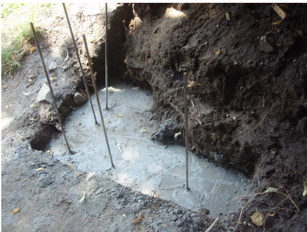
Betonování a armování základů
