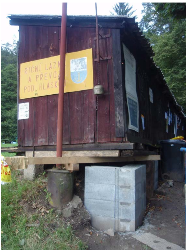
Před spuštěním kabin na novou konstrukci nároží
