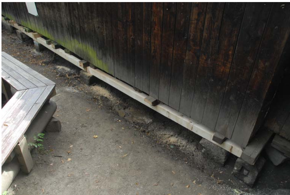
Prohnilé trámy roštu kabin byly vyměněny za nové
