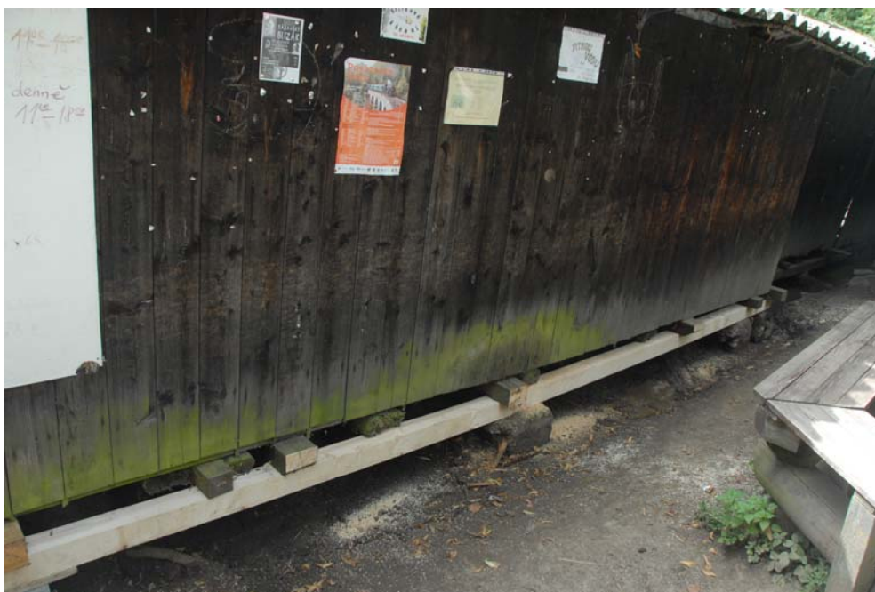
Rošt v zadní části kabin byl nově podložen a dám do roviny s přední částí kabin
