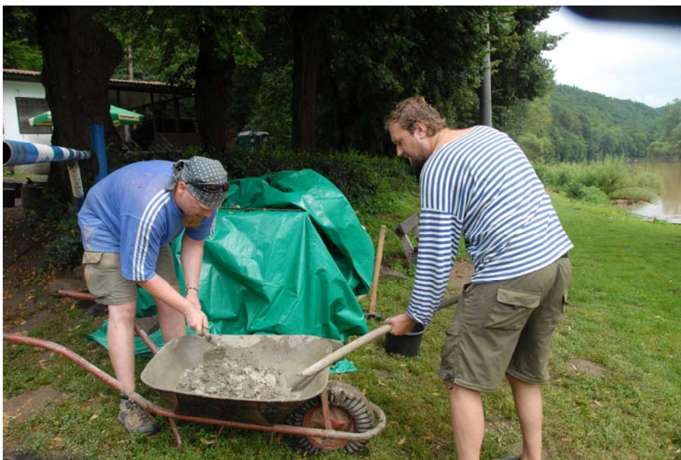
Ruční míchání betonu na stavbu
