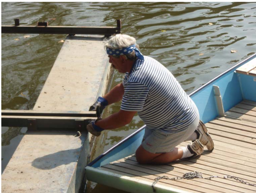
Těsné spojení pontonů
