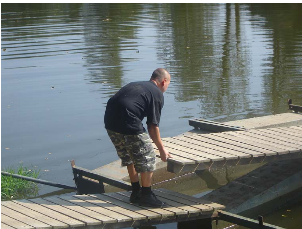
Položení podlážek na konstrukci pontonu
