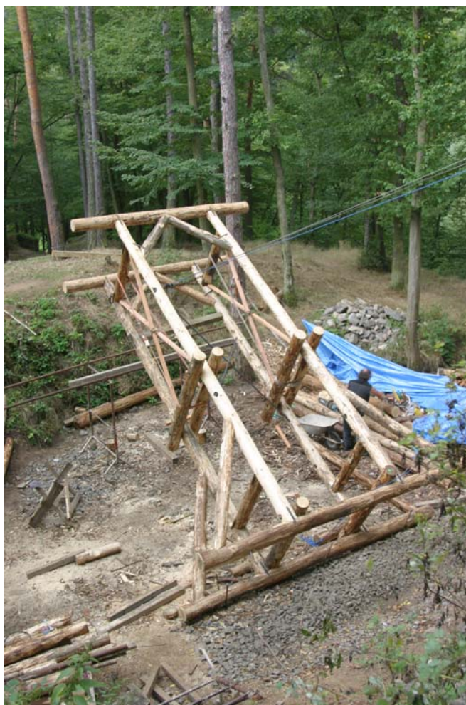
21. srpna – první stojka mostu je postupně zvedána
