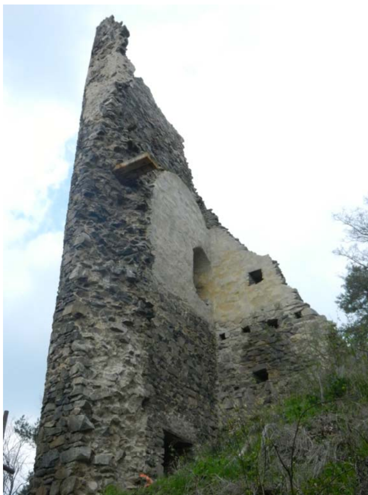
Velká věž (palác) po velké rekonstrukci a obnově
