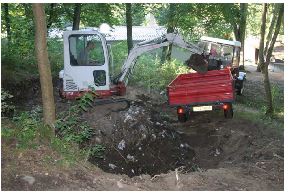
Odvoz bordelu traktorem obecního úřadu
