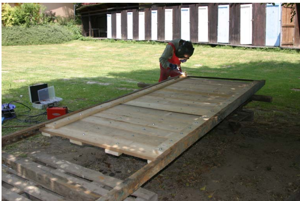
Nově svařená kostra nájezdu
