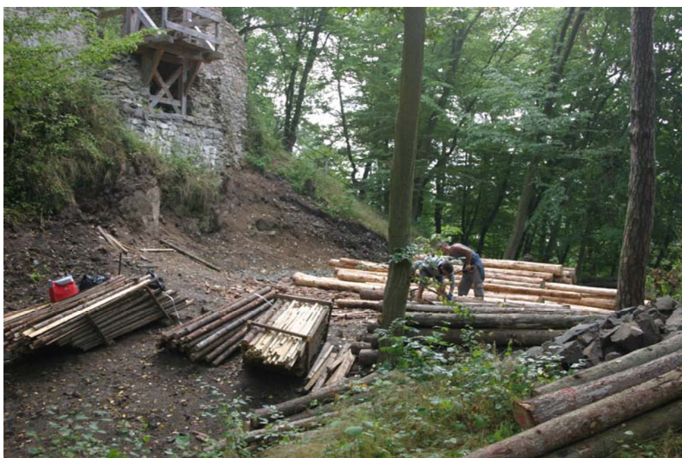
30. července – dorazil materiál na stavbu mostu
