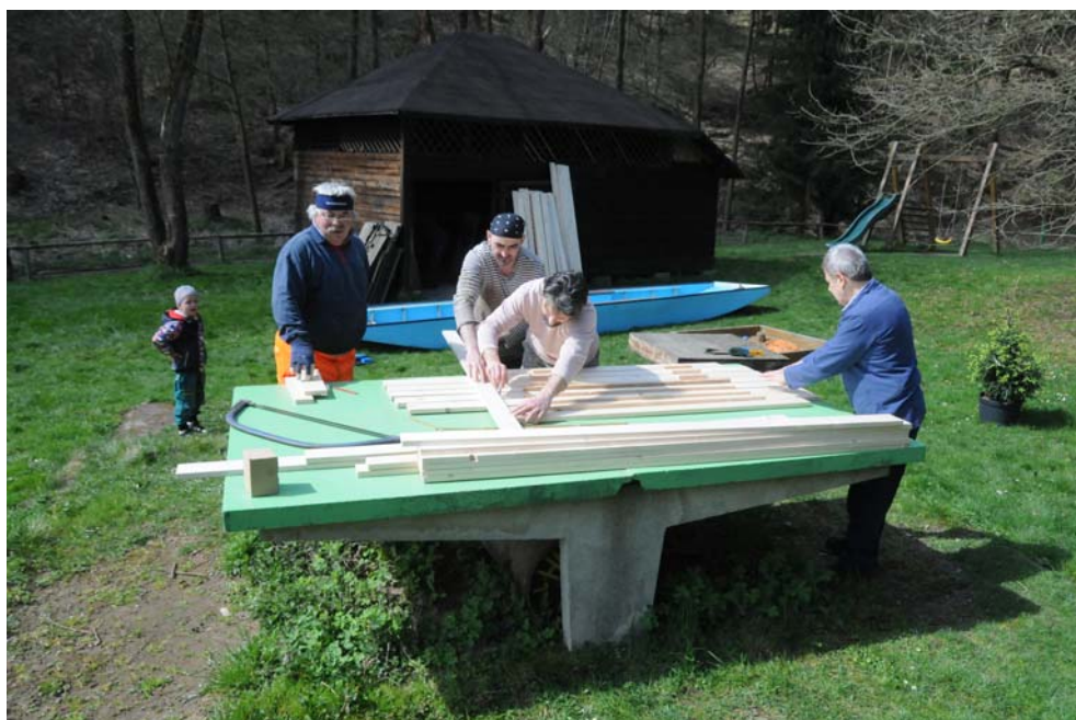
Výroba nových podlážek do převoznické lodi
