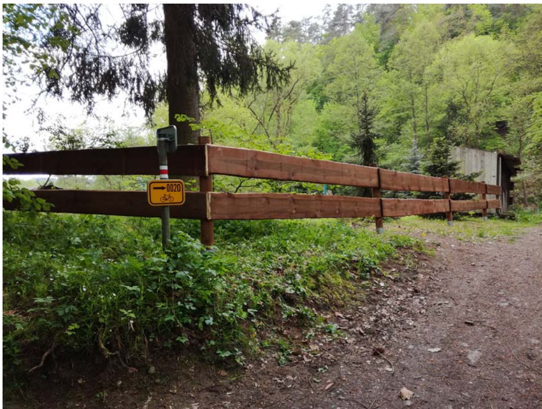
Stavba plotu u mostu přes Mnichovický potok
