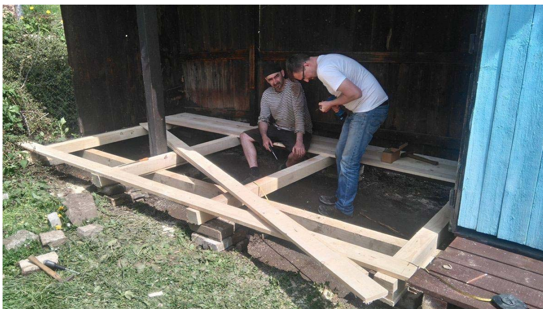
Dokončení nového ochozu v místě pergoly
