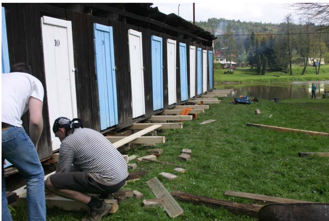
Odtěžení naplaveného materiálu, úklid odpadků pod kabinami a nový trámový rošt
